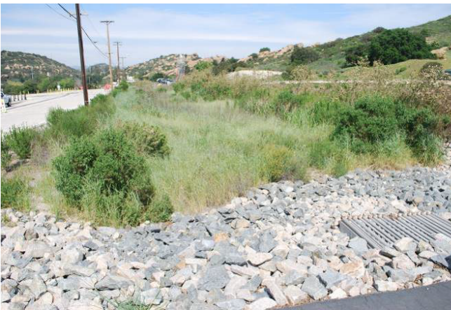
2015: B1436 Detention Bioswales
